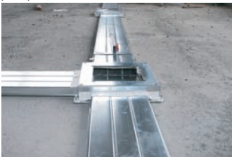
Завершение соединения распределительного ящика
