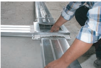
Соедините канал к входу распределительного ящика
