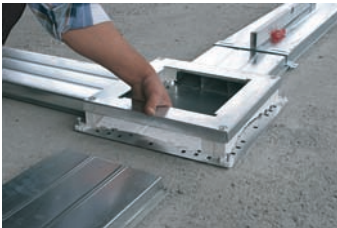
Согните пластик для соединения канала
