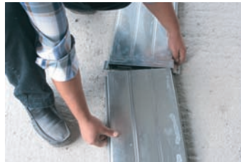
Соедините другой отрезок канала с соединительным элементом
