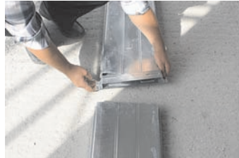
Наденьте соединительный элемент на торец канала
