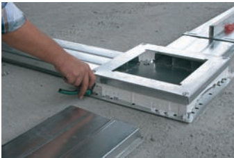
Отрежьте кусок пластика по ширине канала
