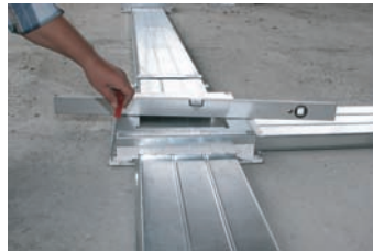
Выровняйте распределительный ящик при помощи уровня
