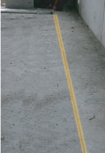
Натяните веревку в соответствии с расположением системы
