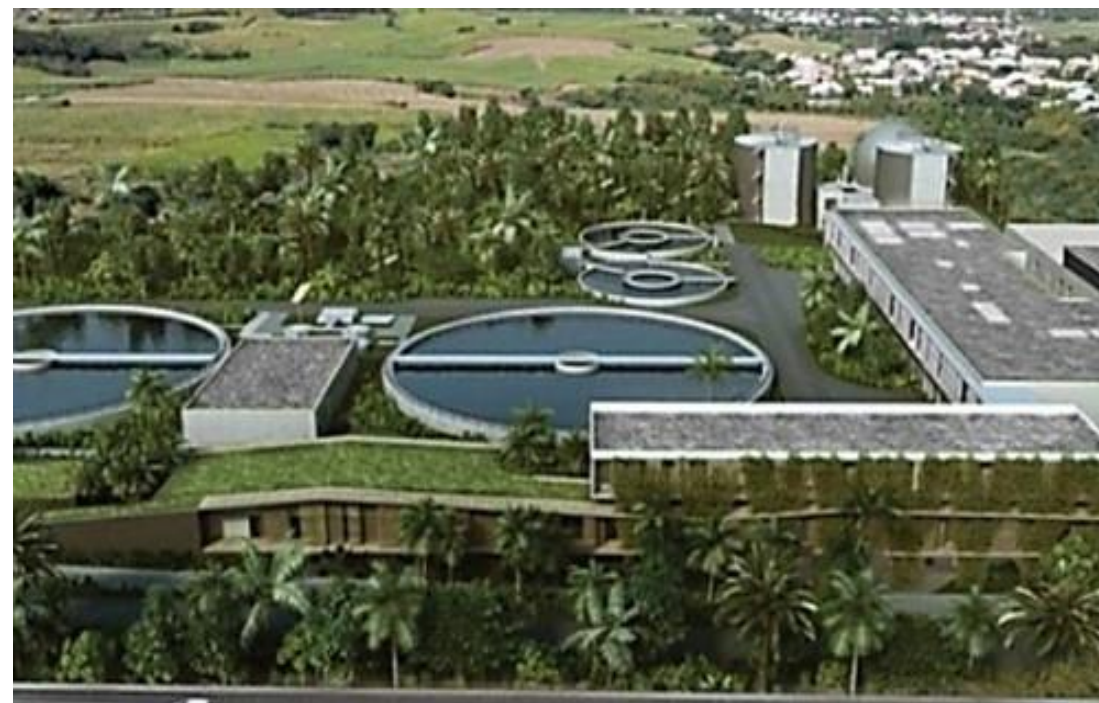
Водоочистные сооружения г. Триполи, Ливан
