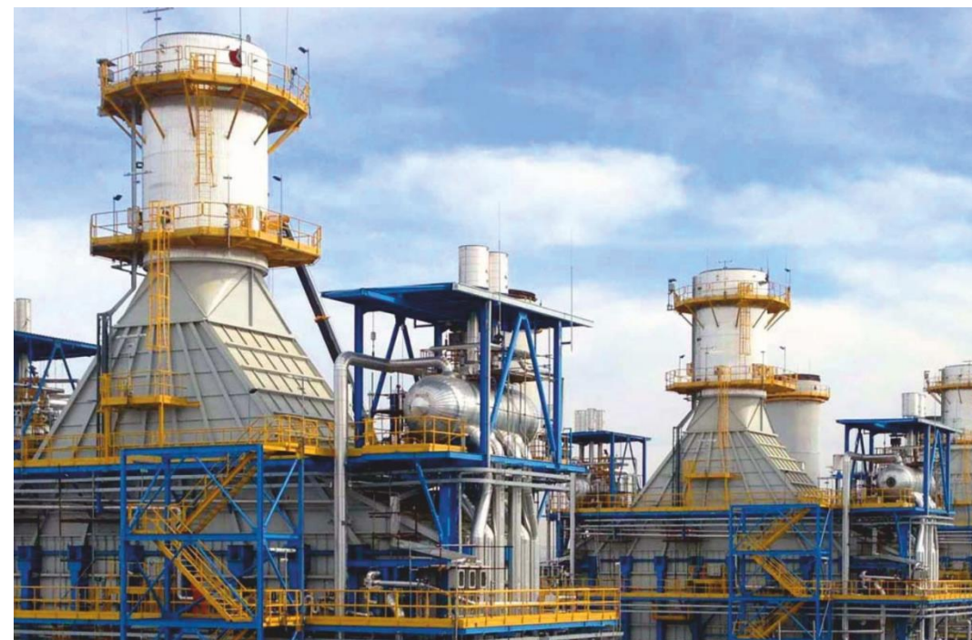
Электростанция с комбинированным циклом (ЭСЦ)
